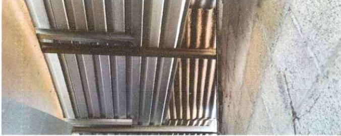
Foto 1: SUSTITUCION DE TECHO, AMPLIACION Y MEJORAMIENTO DE BODEGA
