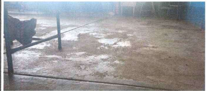
Foto 4: SUSTITUCION DE PISO EN UNA DE LAS AULAS
