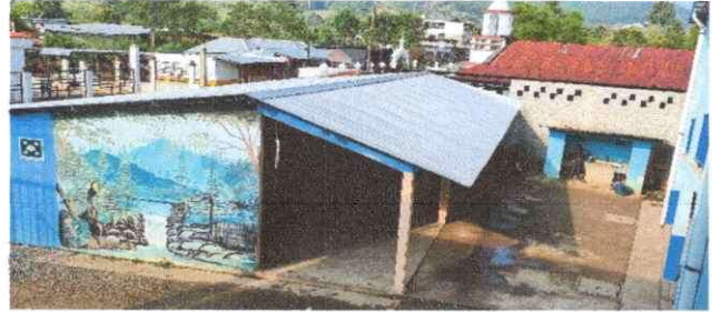
Foto 2: AMPLIACION Y MEJORAMIENTO DEL SALON
