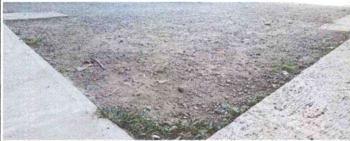
Foto 3: SUSTITUCION DE PISO DE CEMENTO EN EL PATIO DEL ESTABLECIMIENTO
